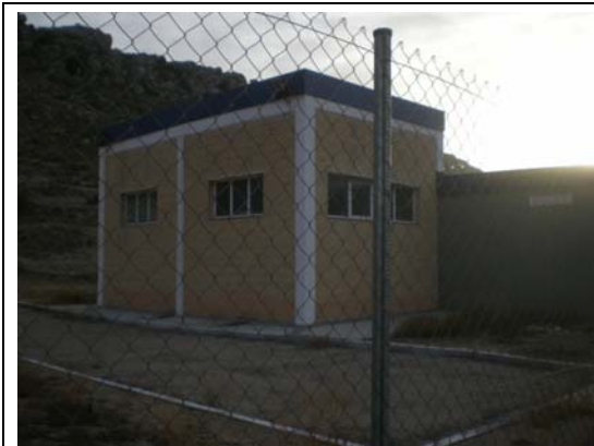
Edificio de llaves ETAP
