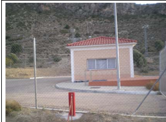
Edificio de Control ETAP
