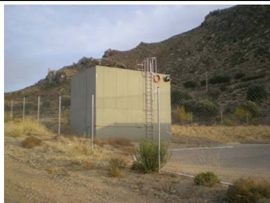
Cámara de descarga ETAP
