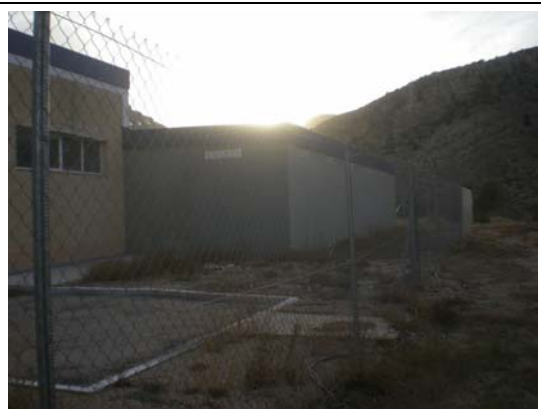
Depósito de agua tratada ETAP
