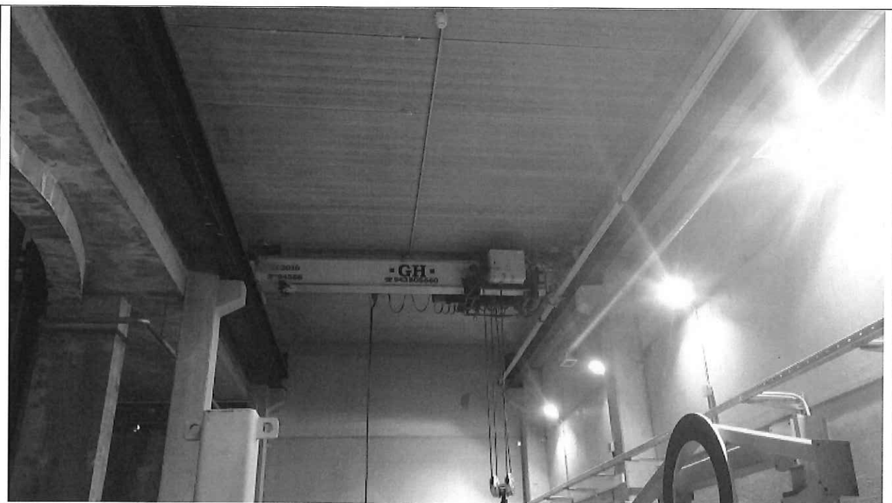
Figura 5. Vista de la zona superior del muelle de carga y puente grúa desde el portón de entrada de camiones (véase Figura 1). En la zona superior izquierda se observa la tubería de nitrógeno líquido.
