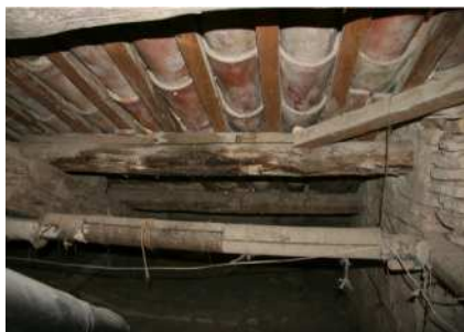
4. ROLLIZO DETERIORADO TABLERO SUR
