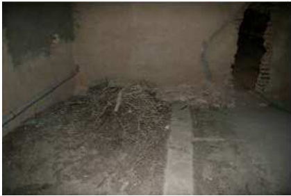
5. ESCOMBRO en el INTERIOR de la FALSA del TABLERO SUR
