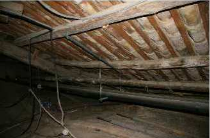
3. ESTRUCTURA del TABLERO SUR MUY DEFORMADA
