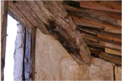
5. DURMIENTE en MAL ESTADO
