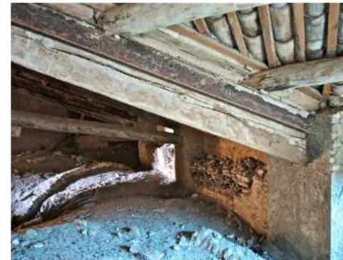
4. REFUERZO METALICO y ESCOMBRO en la FALSA
