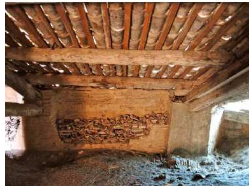
6. FALTA de ESTANQUEIDAD y ESCOMBRO en la FALSA
