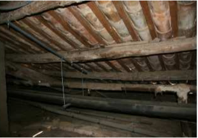
3. INSTALACION OBSOLETA y GRAN DEFORMACIÓN de las VIGAS
