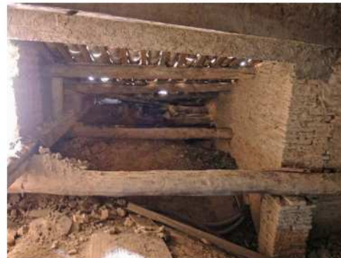
5. FALTA de ESTANQUEIDAD y ESCOMBRO en la FALSA
