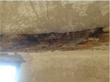
5. DURMIENTE en MAL ESTADO
