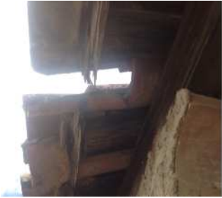
6. DETERIORO del ALERO del MIRADOR
