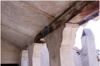
5. DURMIENTE DETERIORADO en el MIRADOR
