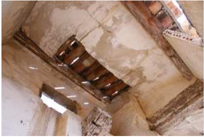
4. DESPRENDIMIENTOS y FALTA de ESTANQUEIDAD en el MIRADOR
