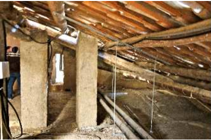
3. FALTA de ESTANQUEIDAD en la FALSA del TABLERO SUR
